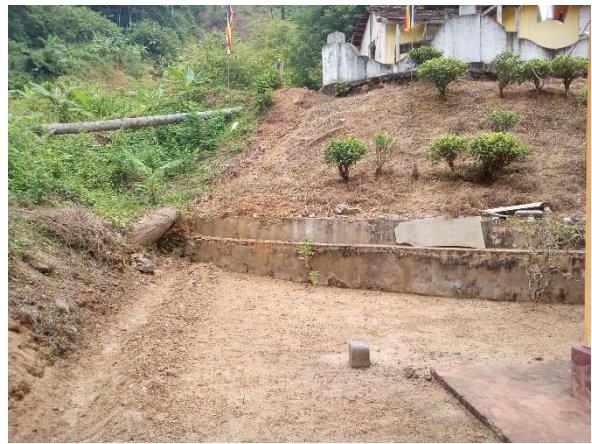
රූපය d: පුදුම සහගත ලෙසින් පන්සල් ගොඩනැගිලි වලට හානියක් නොමැතිව නායයාම් සිදු වී ඇති ආකාරය
