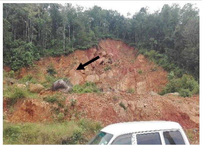
රූපය b : අසාර්ථක බෑවුම හරහා ගමන් කරන ජල සැපයුම් නලය
