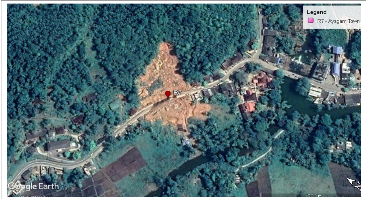
රූපය 1: යෝජිත නායයාම් අවම කිරීමේ ස්ථානයේ ගුගල් ඡායාරූපය .යොමුව: වැඩිදුර අධ්‍යයනය සඳහා ගුවන් ඡායාරූපය ඇමුණුම 1 යටතට ඇතුළත් කර ඇත.
