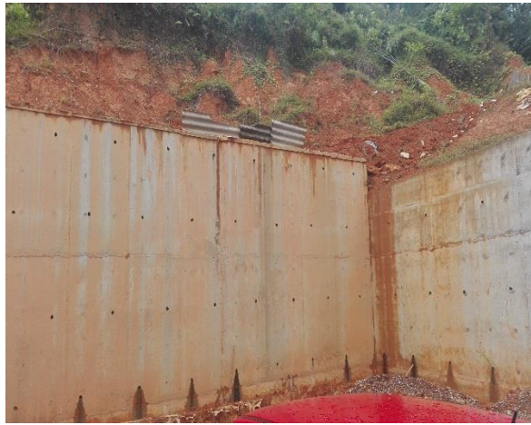
ඡායාරූපය a: පිරවුම් හලේ හිමිකරු විසින් එම ගොඩනැගිල්ලට පිටුපසින් ඉදිකර ඇති ආරක්ෂිත බැම්ම
