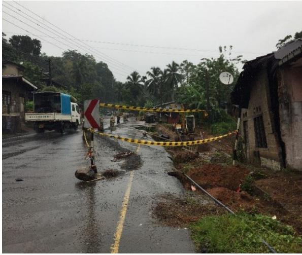
රූප සටහන 2a: සෙමින් පහලට චලනය වන බැවුම හේතුවෙන් හානියට පත් මාර්ගය
