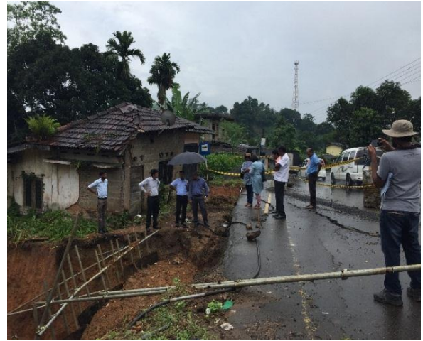
රූප සටහන 2d: අබලන් වූ මාර්ග කොටස සහ ගිලා බැස ඇති පහත බැවුම් කොටස
