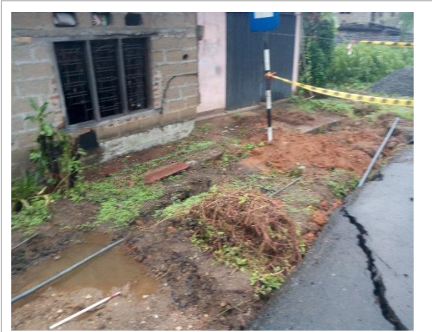
රූපසටහන c: අසන්න වාමර මහතාගේ සම්පූර්ණයෙන්ම විනාශ වූ නිවස සහ මාර්ගයේ ආනති පැල්ම
