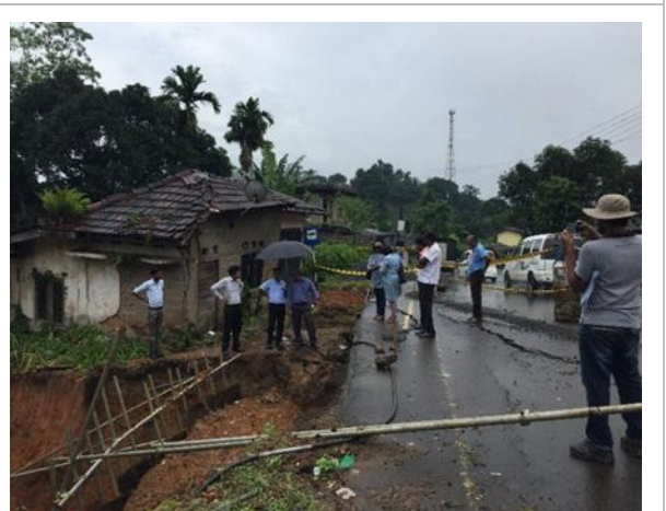
රූපසටහන f: බෑවුමේ වලනය හේතුවෙන් ගිලා බැසීමට ලක්වූ ප්‍රදේශයේ හානි වූ මාර්ග කොටස
