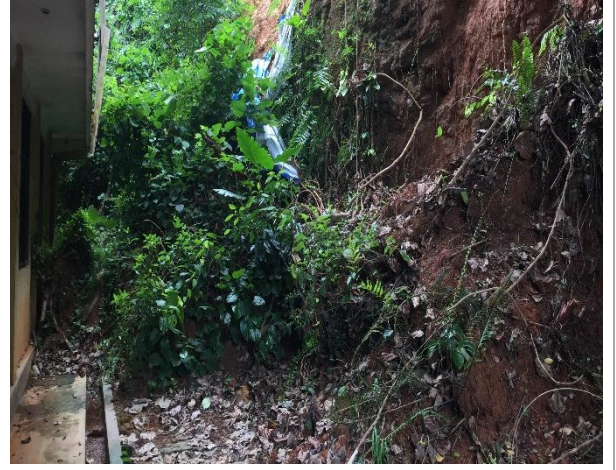
රූපය 2b: දිස්ත්‍රික් කම්කරු කාර්යාල ගොඩනැගිල්ල සහ කන්ද අතර ප්‍රදේශයේ පහලට කඩා වැටුණු පස් සහ සුන්බුන් තැන්පත් වී ඇති ආකාරය.
