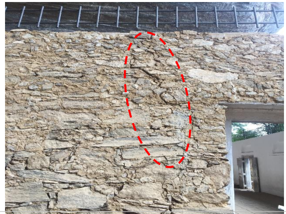
රූපය 2d: ලෙන තුළ පිහිටා ඇති පැරණි විහාර මන්දිරයේ බිත්ති වල ඇති ආතති පැළුම්
