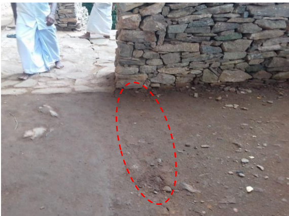
රූපය 2c: ලෙන තුළ පිහිටා ඇති පැරණි විහාරයේ පොළව තුළ ඇති ආතති පැළුම්
