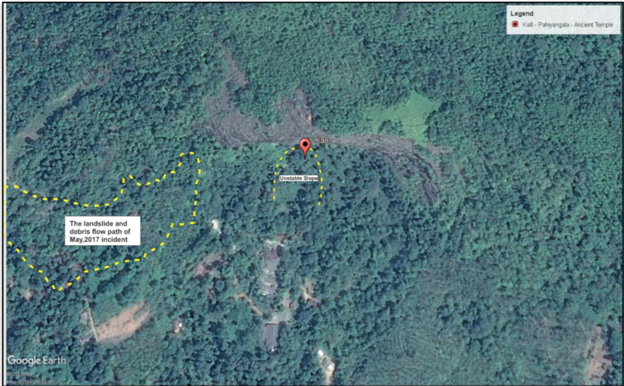
රූපය 1. යෝජිත නායයෑම් අවම කිරීමේ සිටානයේ ගුහල් ඡායාරූපය - වැඩිදුර අධ්‍යයනය සඳහා චෝන ඡායාරූපය ඇමුණුම 10 ඇතුළත් කර ඇත.
