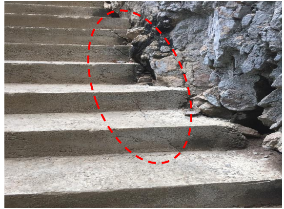
රූපය 2b: ඓතිහාසික ලෙනට පිවිසීම සඳහා අළුතින් ඉදිකරන ලද කොන්ක්‍රීට් පියගැටපෙල හා බිත්තිය අතර කලඳු වී යාම
