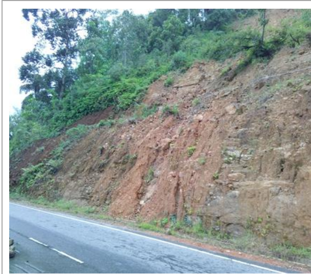
රූපය 2a: අස්ථාවර වීමෙන් පසු නිරාවරණය වූ ඉහළ බෑවුම
