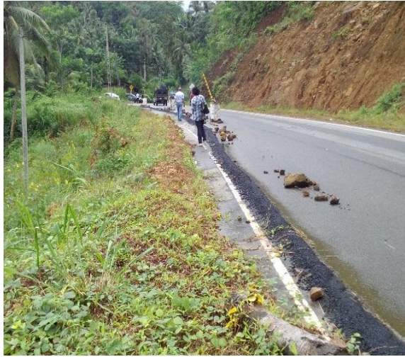
රූපය a: මාර්ගය දිගේ වර්ධනය වී ඇති දිග ආනති පැල්ම
