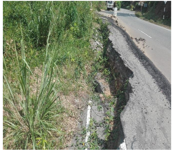
රූපය 2b: හානියට පත් මාර්ගය සහ මාර්ගයේ අයින දිගේ නිර්මාණය වී ඇති ආතති පැලුම්
