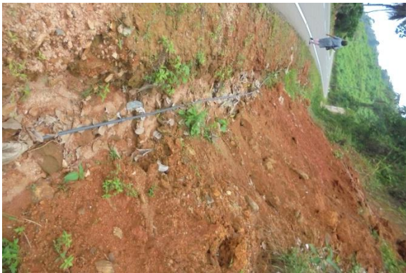
රූපය 2c: පාදම ප්‍රදේශය තුළ දිවෙන ජල සැපයුම් නල මාර්ගය
