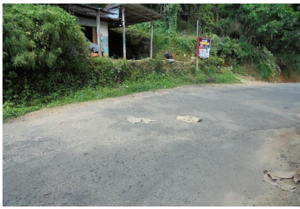
රූපය 2c. පාරේ ආතති පැළුමක් (මාර්ග සංවර්ධන අධිකාරිය තාර දමා සිදුරු ආවරණය කර ඇත)
